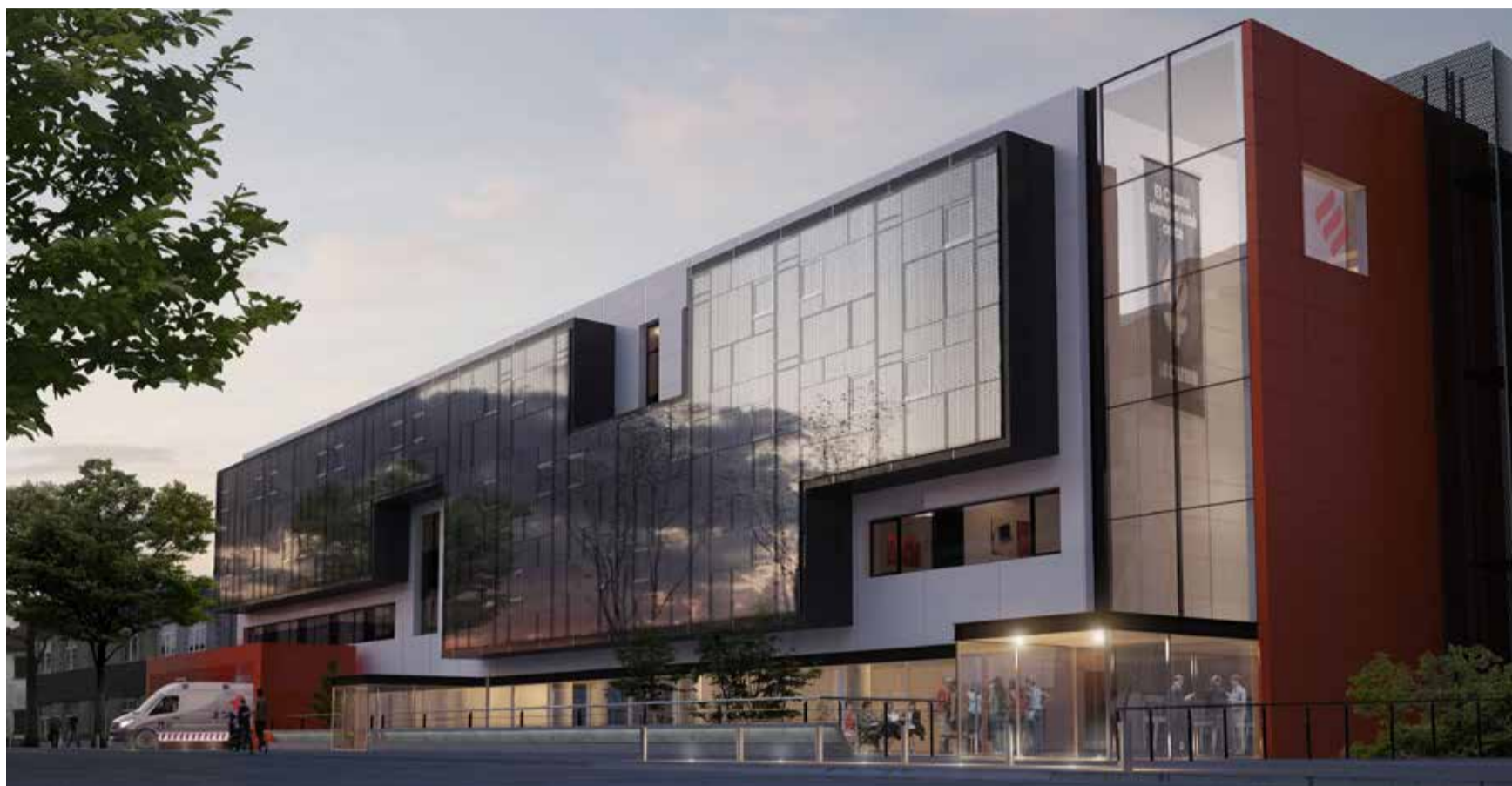
Fachada calle Asilo.
